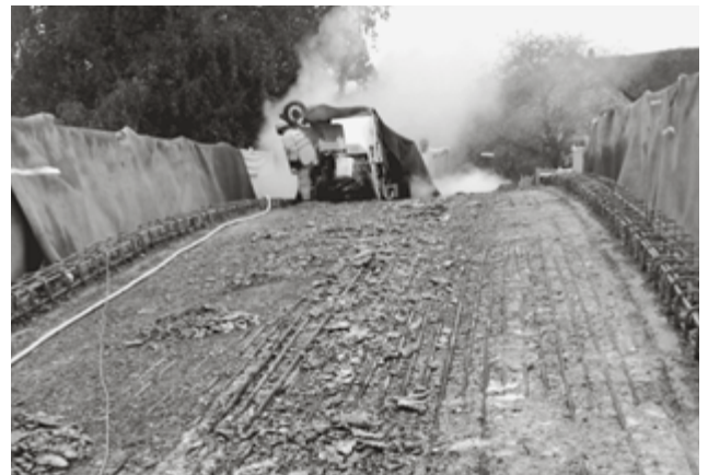
Mit umfangreichen Sanierungsmassnahmen wird die Fussgängerbrücke Gsteigstrasse für die kommenden vierzig Jahre fit gemacht. (Bild: TAZ)
