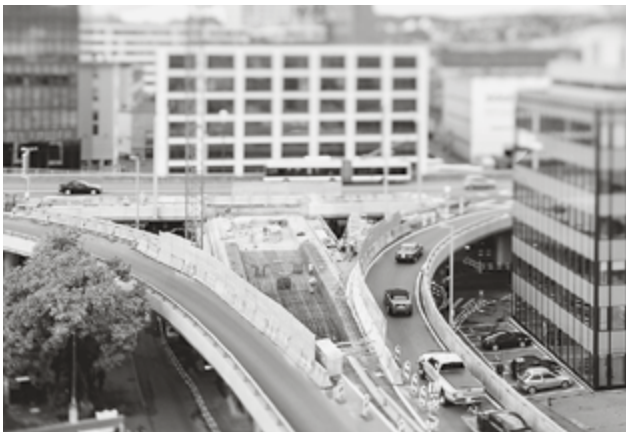
Die Bauarbeiten fürs Tram über die Hardbrücke sind 2015 mit dem Bau der dritten Geroldrampe angelaufen. (Bild: Daniel Sutter)
